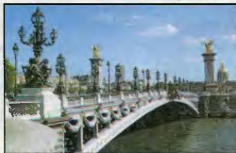
Мост Александра III
